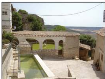
Fuente y lavadero de Horche
