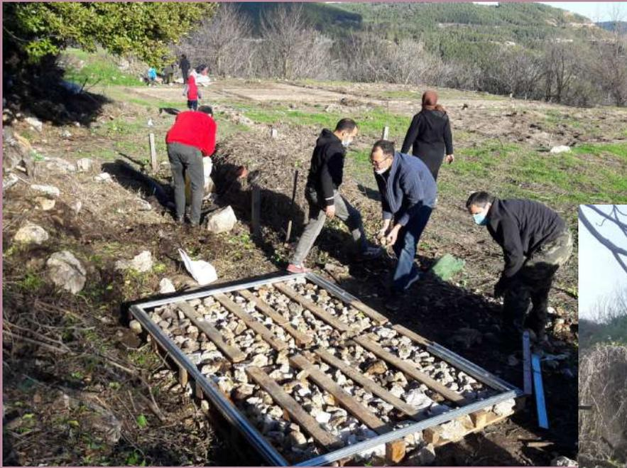
*Construcción de muretes de piedra para la elevación de los depósitos de agua*
